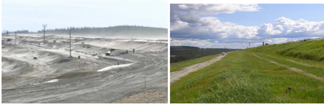
Рис. 3. Создание биогеобарьера на хвостохранилище ОАО «Ковдорский ГОК».
